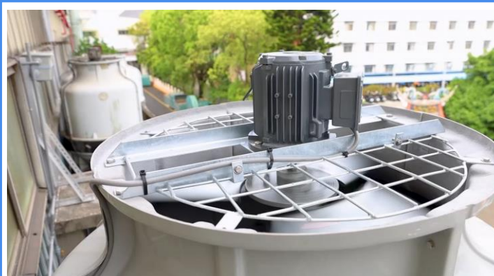
案例II: 東元中壢廠新建直驅冷卻水塔
